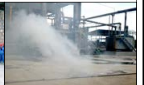
● 炉精制槽底部发生黄磷泄漏
